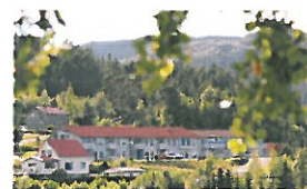
Foto: Svein Tore Kolstad
